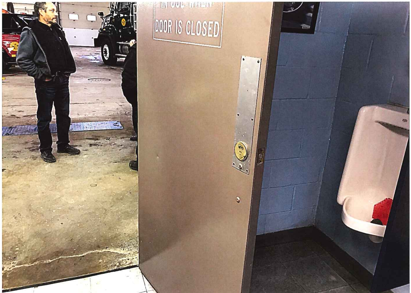
(BE-6) Missing accessible door hardware
